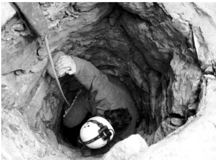
Foto 31: Miriam descendiendo por el "pozo", construido para evitar que se volviera a azolar el acceso al resumidero.
